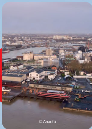
Construction, réparation navale et infrastructure
