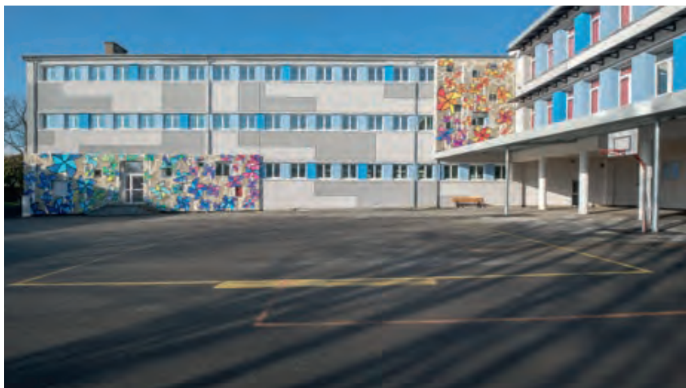
La Ville de Brest a confié à BMa la rénovation énergétique de cinq groupes scolaires via un marché de partenariat de performance énergétique © Jean-Philippe Corre
