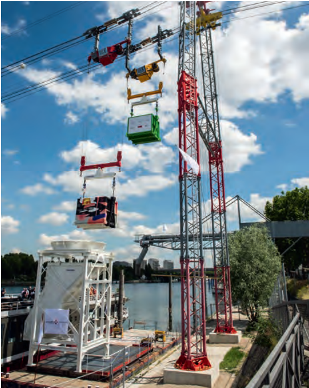
Un téléphérique spécialement construit pour transporter les gravats jusqu'aux berges afin d'éviter la pollution causée par les camions © Philippe Couette - Ville de Clichy
