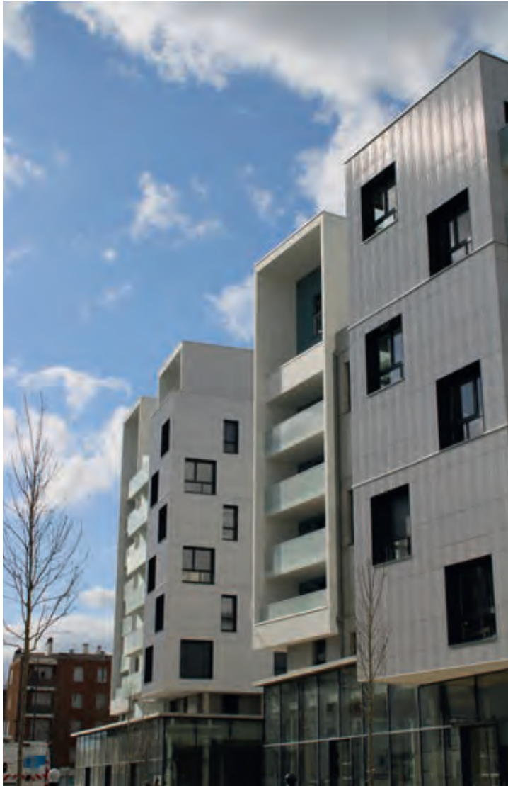
Un immeuble de 54 logements chauffé par les couloirs du métro © Néotoa
